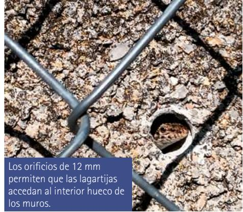
Los orificios de 12 mm permiten que las lagartijas accedan al interior hueco de los muros.
